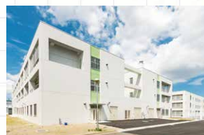
収容施設(新潟刑務所)
